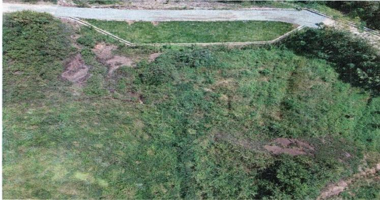
对边坡处平整场地、设置排水沟、栽种植物，并覆盖裸露区域，覆盖绿网 400 平，播撒草籽 15 公斤，场地平整约 600 平
